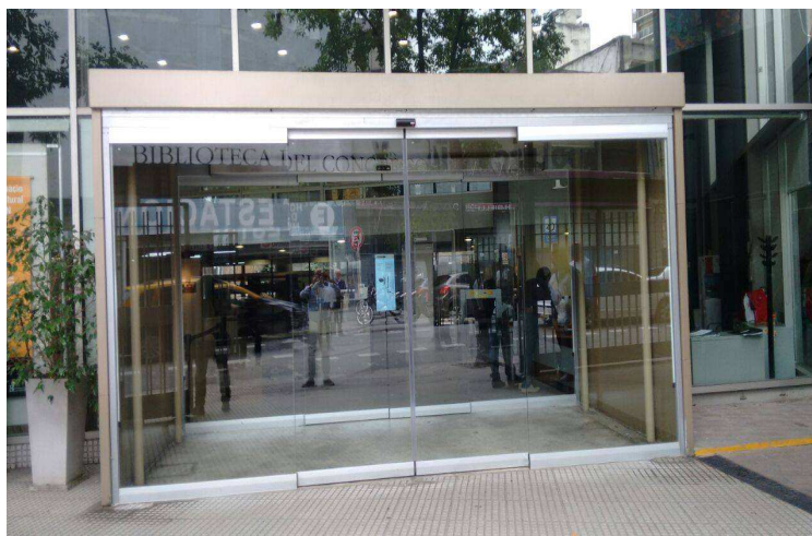
imagen puerta automática zócalo dintel
